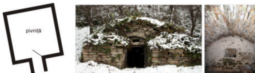
Fig. 4. Ceru Bacainti. Pivnita cu bolta semicilindrica din lespezi tesute
