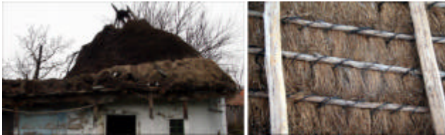
Fig. 9. Ceru Bacainti. Casa veche cu învelitoare din paie în patru ape și detaliu cu tehnica realizării acesteia
