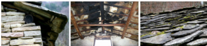
Fig. 10. Ceru Bacainti. Acoperis si structura de sarpanta cu învelitoare din lespezi de piatra
