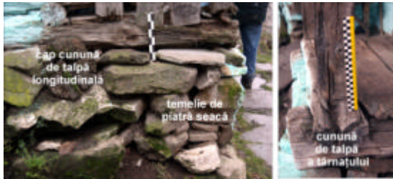
Fig. 13. Catunul Bulbuc. Temelie din piatra seaca si tipuri de îmbinari ale talpilor
