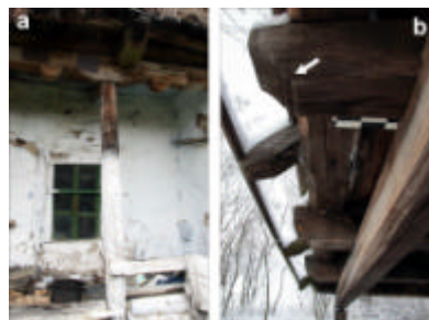
Fig. 15. Catunul Bulbuc. Detaliu de suport si muruiala
