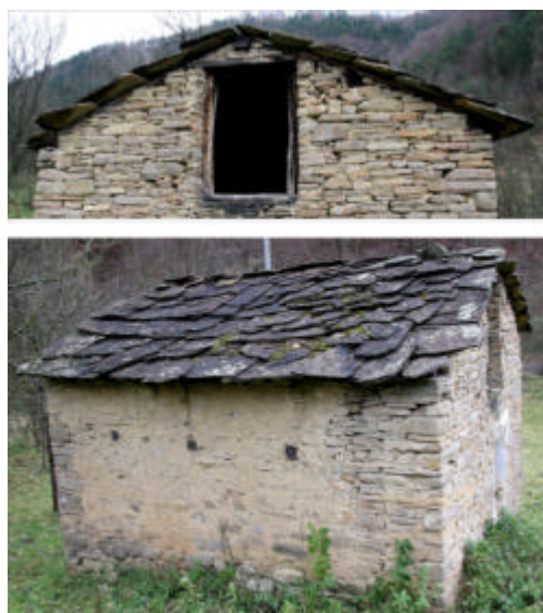
Fig. 5. Ceru Bacainti. Detalii de zidarie supratrana si fronton
